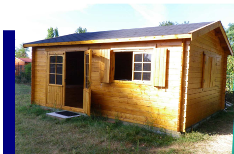
Le local, enfin installé et aménagé !
